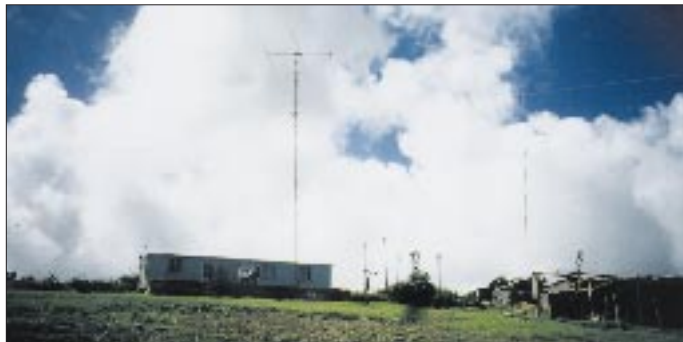
Der Standort von ZD7WRG bzw. ZD7VJ mit 20-m-Mast und Dreiband-Yagi; gelegen auf einem Bergrücken etwa 420 m über dem Meer mit freiem Blick in Richtung Norden
